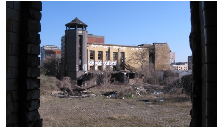
Abb. 5: Halle: Alte Brauerei (2009)
