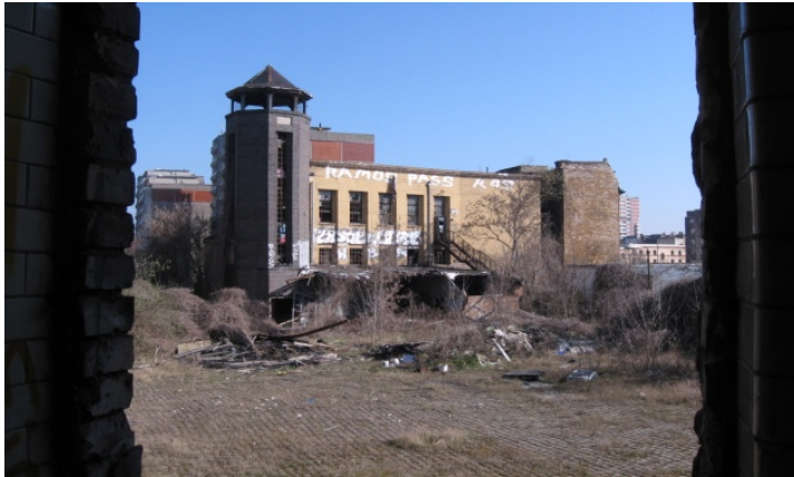
Abb. 5: Halle: Alte Brauerei (2009)
