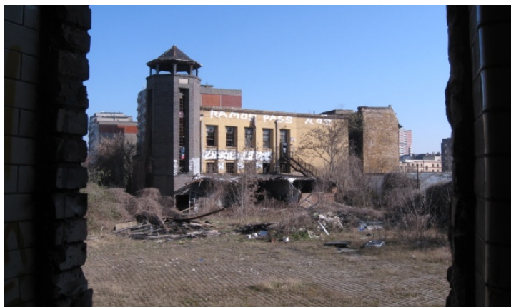
Abb. 5: Halle: Alte Brauerei (2009)
