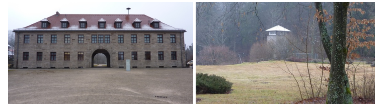
Fig. 5 : Mémorial Camp de Flossenbürg, Allemagne, © I. Millières, DRAC PACA
