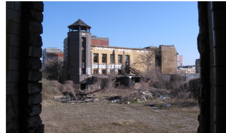
Abb. 5: Halle: Alte Brauerei (2009)
